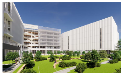
▲ 과천 신사옥과 데이터센터 조감도 (과천 지식정보타운 내)
